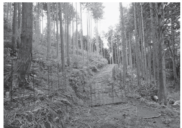
路網が整備されたことにより、イノシシなどの被害を防止するために、簡単にワイヤーメッシュを設置することができ、地域の獣害対策にも貢献しています。
