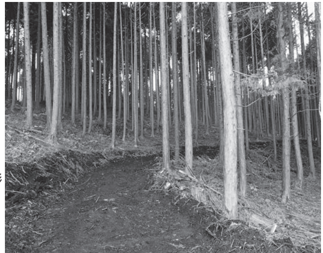
搬出間伐を行った区域の路網を、完了時には路面整形を行い災害防止にも努めています。
