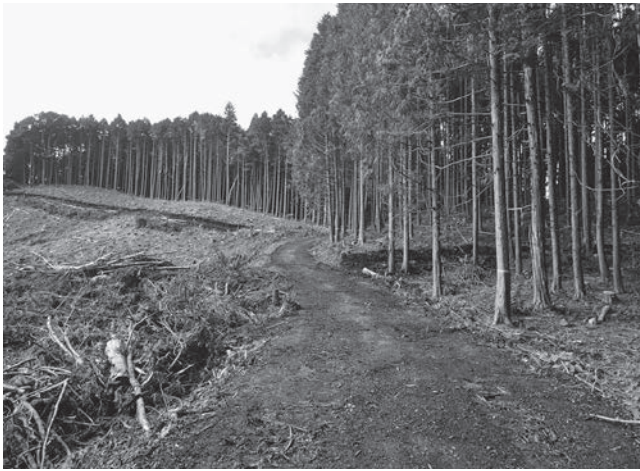
搬出間伐を行った区域の路網を、完了時には路面整形を行い災害防止にも努めています。
