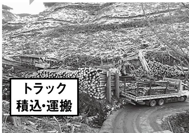
トラック積込・運搬 (専属業者)
